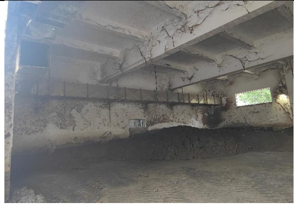
现有二期污泥暂存间
