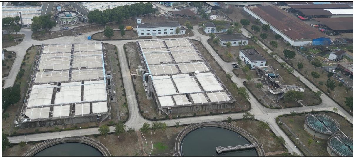
现有二期航拍图（局部）
