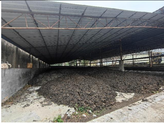
现有一期污泥暂存间
